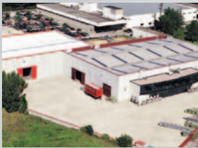
Usine de Gerona (Espagne) Fabriek in Gerona (Spanje) Werk Gerona (Spanien) Factory at Gerona (Spain)
